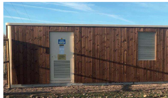
Photo 7. Exemple de poste de livraison avec bardage bois
